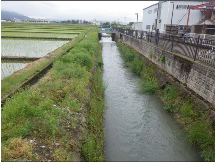
野々市市下林2丁目地内 富樫用水 延長約50m 草刈工 着手前
