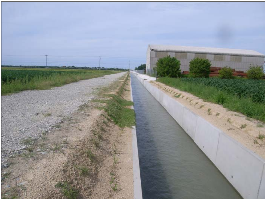
白山市相川町地内 山島用水 延長 270m 草刈工 完了
