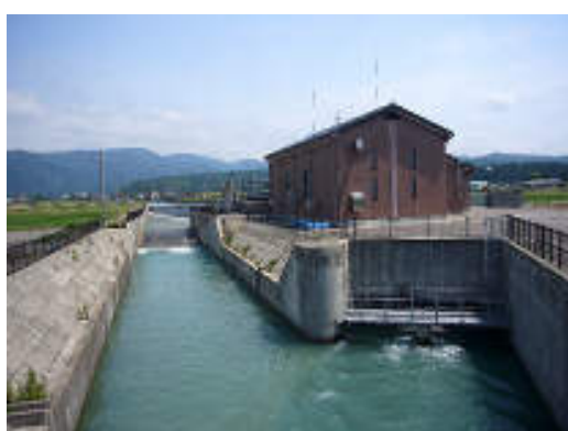
④七ヶ用水発電所
