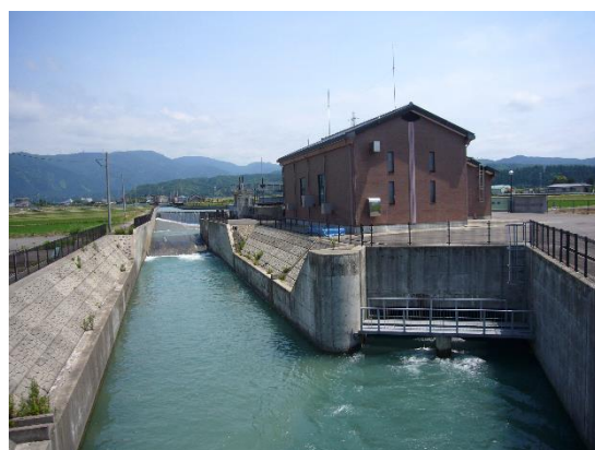
④七ヶ用水発電所
