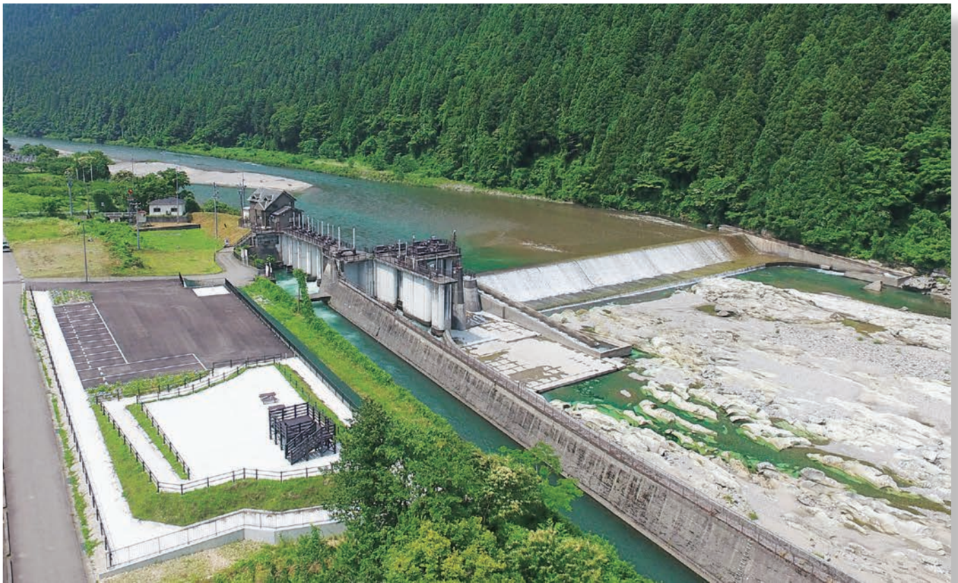
白山頭首工と頭首工を望む視点場
